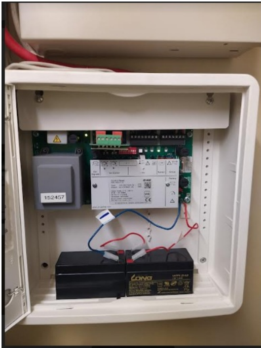
Akut 12v 3,2AH 2kpl vaihdettu 20.6.2023
