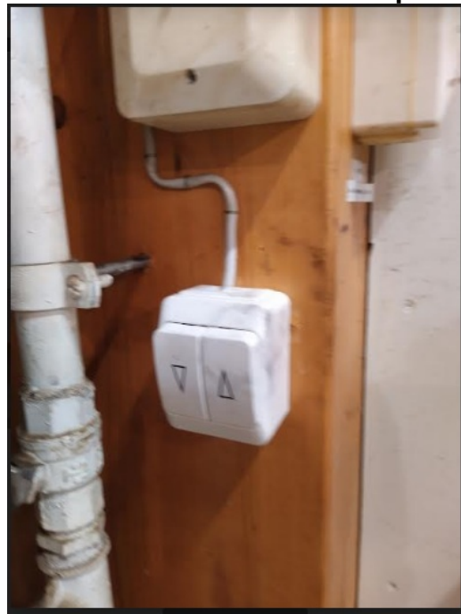
Tuuletuskäyttöön tarkoitettu painike, avataan n.45 asteen kulmaan ei automatiikkaa sateen varalle.
