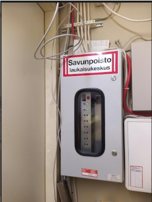
Akut 2kpl 2,3 AH, vaihdettu 2019, Akut Vaihdettu 20.6.2023
